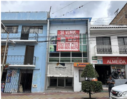
VISTA GENERAL DE LA FACHADA
